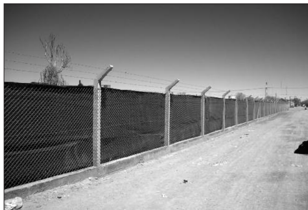
FIGURA 6. Vista del predio de Metal Huasi mientras se realizaba el traslado de la montaña de escoria.
