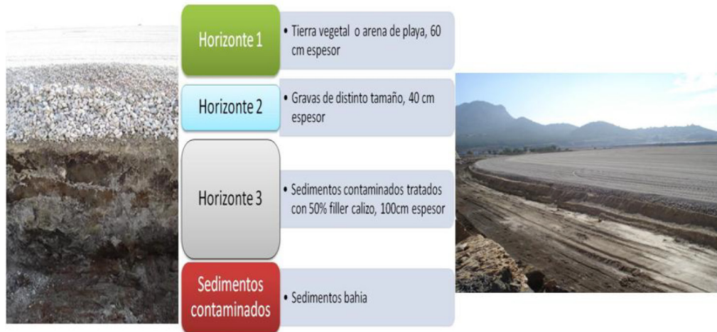
Figura 5. En la parte izquierda de la figura, fotografía del perfil del suelo y en la parte derecha una panorámica de la parcela en construcción. En el centro, esquema del Tecnosol construido en las parcelas experimentales
